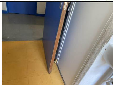
Photo n° PhA730 Localisation : 4ème étage - L403 - Chambre Ouvrage : Dessous de porte d'entrée Description : Joint souple noir à lèvres Localisation sur croquis : 730 Amiante : Non détecté
