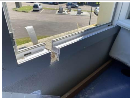
Photo n° PhA753 Localisation : 1er étage - L127 - Chambre Ouvrage : Dormant pvc Description : Joint souple gris à lèvre Localisation sur croquis : 753 Amiante : Non détecté
