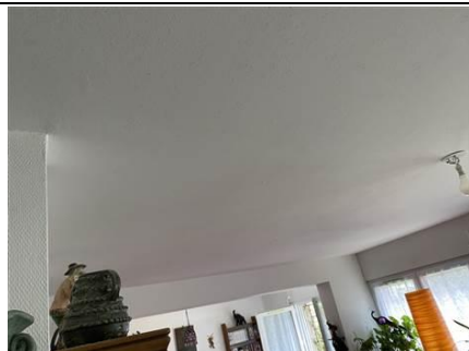
Photo n° PhA688 Localisation : Rez de chaussée - Logement gardien - Séjour Ouvrage : Plafond Description : Peinture + enduit blanc + béton gris Localisation sur croquis : 688 Amiante : Chrysotile
