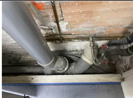
Photo n° PhA761 Localisation : 1er étage - Gaine technique - Dégagement Ouvrage : Sol Description : Béton gris Localisation sur croquis : 761 Amiante : Non détecté
