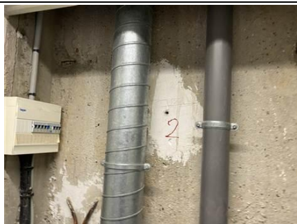
Photo n° PhA733 Localisation : 4ème étage - Gaine technique - Dégagement Ouvrage : Rebouchage Description : Enduit blanc Localisation sur croquis : 733 Amiante : Non détecté
