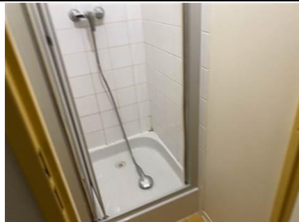
Photo n° PhA170 Localisation : 4ème étage - Logement 420 - Salle de bain Ouvrage : Mur Description : Colle blanche de faïence Localisation sur croquis : 170 Amiante : Non détecté
