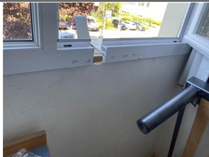
Photo n° PhA745 Localisation : 1er étage - L122 - Chambre Ouvrage : Mur de doublage Description : Peinture + plâtre blanc Localisation sur croquis : 745 Amiante : Non détecté
