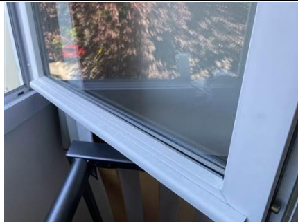
Photo n° PhA746 Localisation : 1er étage - L122 - Chambre Ouvrage : Dormant pvc Description : Joint souple gris à lèvre Localisation sur croquis : 746 Amiante : Non détecté
