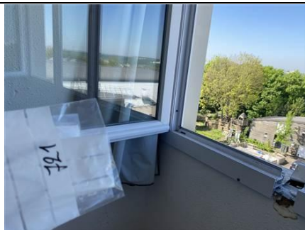
Photo n° PhA721 Localisation : 4ème étage - L407 - Chambre Ouvrage : Vitrage Description : Joint souple gris Localisation sur croquis : 721 Amiante : Non détecté
