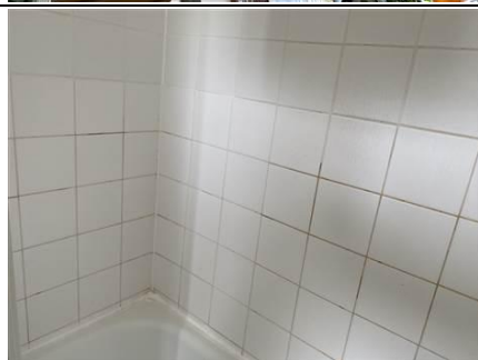
Photo n° PhA689 Localisation : Rez de chaussée - Logement gardien - Salle de bain Ouvrage : Mur Description : Colle grise de faïence Localisation sur croquis : 689 Amiante : Non détecté
