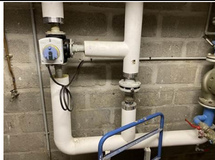
Photo n° PhA697 Localisation : Sous sol Ouvrage : Calorifugéage Description : Enduit blanc + matériaux dur noir + fibre jaune isolante Localisation sur croquis : 698 Amiante : Non détecté
