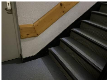
Photo n° PhA766 Localisation : 1er étage - Escalier 1 Ouvrage : Mur Description : Colle jaune de plinthe Localisation sur croquis : 766 Amiante : Non détecté
