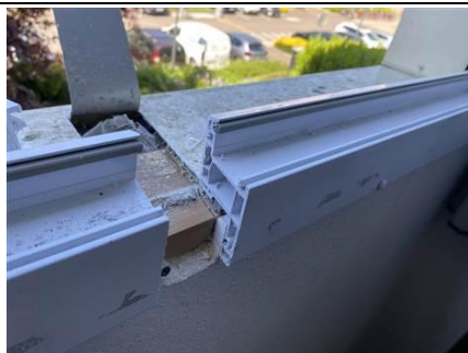
Photo n° PhA743 Localisation : 1er étage - L122 - Chambre Ouvrage : Vitrage Description : Joint mousse grise Localisation sur croquis : 743 Amiante : Non détecté
