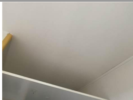
Photo n° PhA278 Localisation : 3ème étage - Logement 308 - Chambre Ouvrage : Plafond Description : Peinture + enduit blanc + béton gris Localisation sur croquis : 278 Amiante : Non détecté
