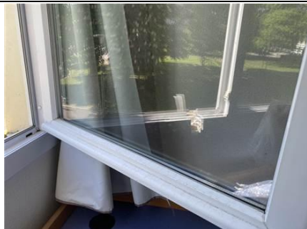
Photo n° PhA754 Localisation : 1er étage - L127 - Chambre Ouvrage : Vitrage Description : Joint souple gris Localisation sur croquis : 754 Amiante : Non détecté
