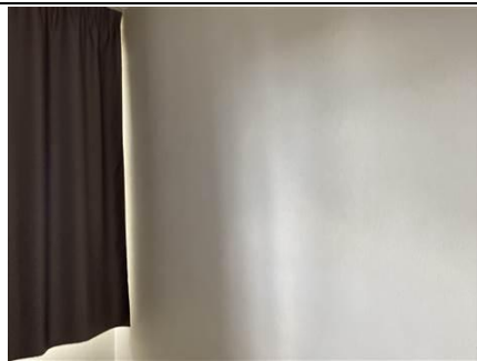
Photo n° PhA277 Localisation : 3ème étage - Logement 308 - Chambre Ouvrage : Mur porteur Description : Peinture + enduit blanc + béton gris Localisation sur croquis : 277 Amiante : Non détecté
