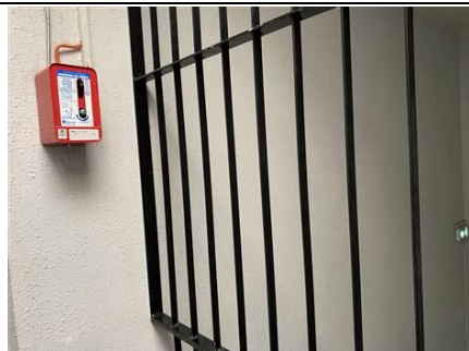
Photo n° PhA180 Localisation : 4ème étage - Escalier Ouvrage : Mur porteur Description : Peinture + enduit blanc + béton gris Localisation sur croquis : 180 Amiante : Non détecté
