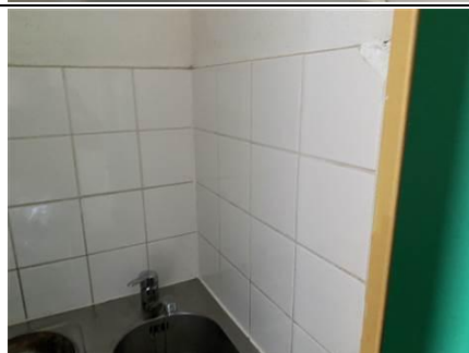
Photo n° PhA279 Localisation : 3ème étage - Logement 308 - Chambre Ouvrage : Mur Description : Colle grise de faïence Localisation sur croquis : 279 Amiante : Non détecté
