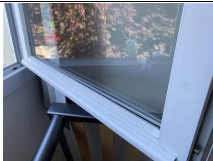
Photo n° PhA747 Localisation : 1er étage - L122 - Chambre Ouvrage : Vitrage Description : Joint souple gris Localisation sur croquis : 747 Amiante : Non détecté
