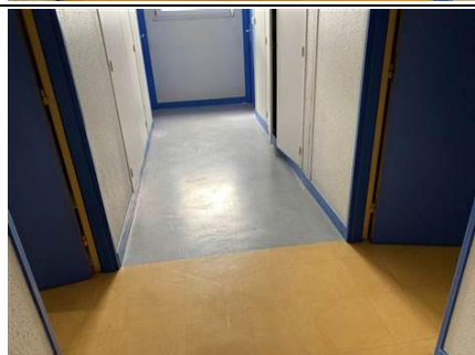
Photo n° PhA172 Localisation : 4ème étage - Dégagement Ouvrage : Sol Description : Dalle de sol souple + colle jaune + ragréage gris Localisation sur croquis : 172 Amiante : Non détecté
