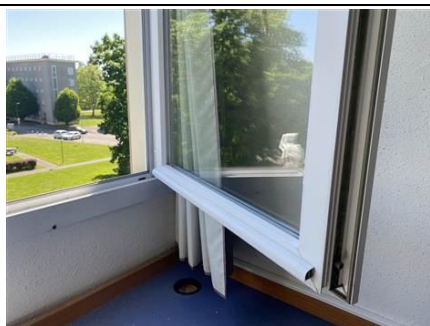
Photo n° PhA728 Localisation : 4ème étage - L403 - Chambre Ouvrage : Vitrage Description : Joint souple gris Localisation sur croquis : 728 Amiante : Non détecté
