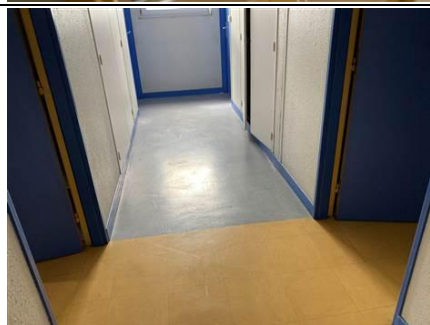
Photo n° PhA171 Localisation : 4ème étage - Dégagement Ouvrage : Sol Description : Dalle de sol souple + colle jaune + ragréage gris Localisation sur croquis : 171 Amiante : Non détecté
