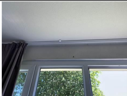
Photo n° PhA755 Localisation : 1er étage - L127 - Chambre Ouvrage : Coffrage Description : Peinture + plâtre blanc + béton gris Localisation sur croquis : 755 Amiante : Non détecté
