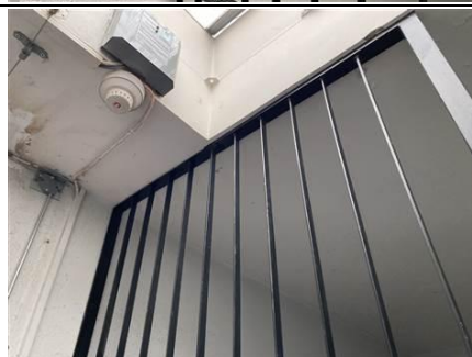
Photo n° PhA181 Localisation : 4ème étage - Escalier Ouvrage : Plafond Description : Peinture + enduit blanc + béton gris Localisation sur croquis : 181 Amiante : Non détecté
