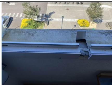
Photo n° PhA718 Localisation : 4ème étage - L407 - Chambre Ouvrage : Entre bâti bois et dormant pvc Description : Joint souple blanc Localisation sur croquis : 718 Amiante : Non détecté
