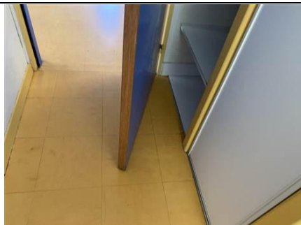
Photo n° PhA756 Localisation : 1er étage - L127 - Chambre Ouvrage : Dessous de porte d'entrée Description : Joint souple noir à lèvre Localisation sur croquis : 756 Amiante : Non détecté
