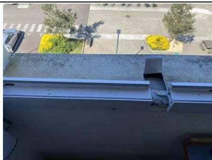
Photo n° PhA719 Localisation : 4ème étage - L407 - Chambre Ouvrage : Sur dormant Description : Joint souple gris à lèvres Localisation sur croquis : 719 Amiante : Non détecté
